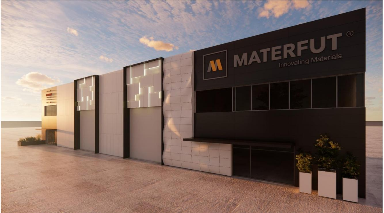
Sede central de Materfut® en Portugal. La fachada con paneles Corian® Exteriors (hechos con Corian® Solid Surface) muestran diferentes posibilidades de formado, incluyendo paneles de formas orgánicas creados con diseño paramétrico; Proyecto del arquitecto Alexandre Sousa Lopes; fabricación e instalación, Materfut®; Imagen Materfut®, todos los derechos reservados.
