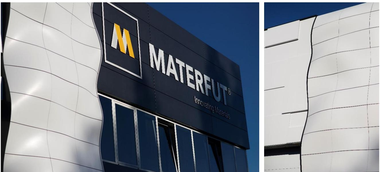
Sede central de Materfut® en Portugal. La fachada con paneles Corian® Exteriors (hechos con Corian® Solid Surface) muestran diferentes posibilidades de formado, incluyendo paneles de formas orgánicas creados con diseño paramétrico; Proyecto del arquitecto Alexandre Sousa Lopes; fabricación e instalación, Materfut®; Imagen Materfut®, todos los derechos reservados.
