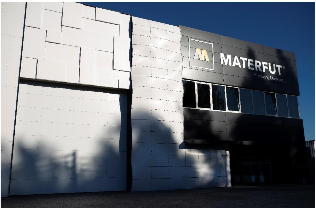
Sede central de Materfut® en Portugal. La fachada con paneles Corian® Exteriors (hechos con Corian® Solid Surface) muestran diferentes posibilidades de formado, incluyendo paneles de formas orgánicas creados con diseño paramétrico; Proyecto del arquitecto Alexandre Sousa Lopes; fabricación e instalación, Materfut®; Imagen Materfut®, todos los derechos reservados.
